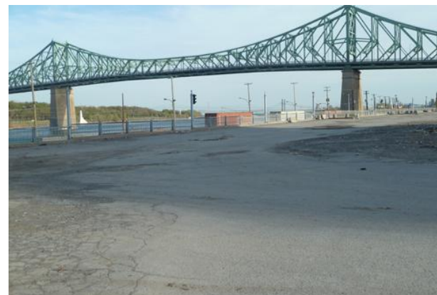
Dépôt à neige municipal
