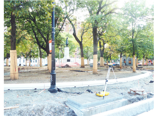
Travaux de réfection du Square Cabot
